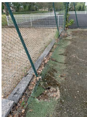
Soulèvement des dalles à cause du grillage
