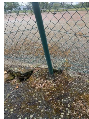
Pied du grillage Dalle complètement soulevée
